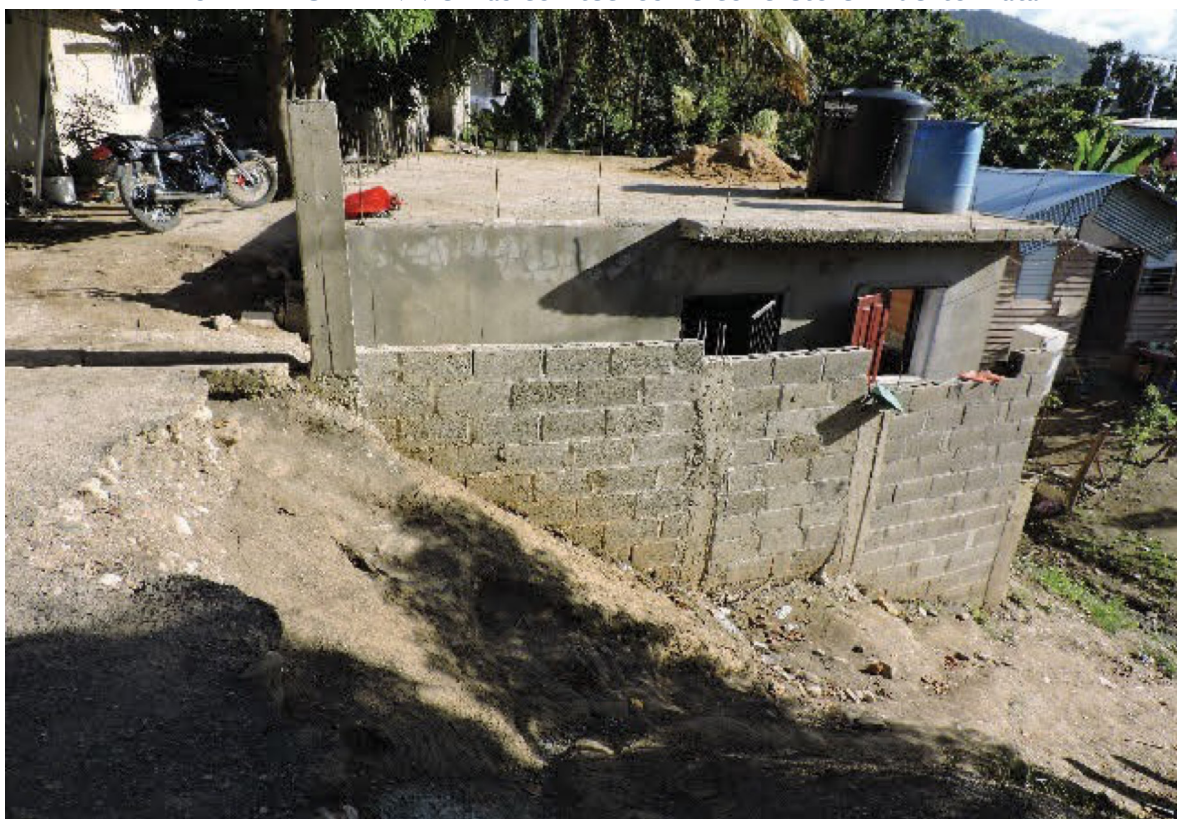
Ilustración 7. Viviendas con techos de concreto en Puerto Plata
