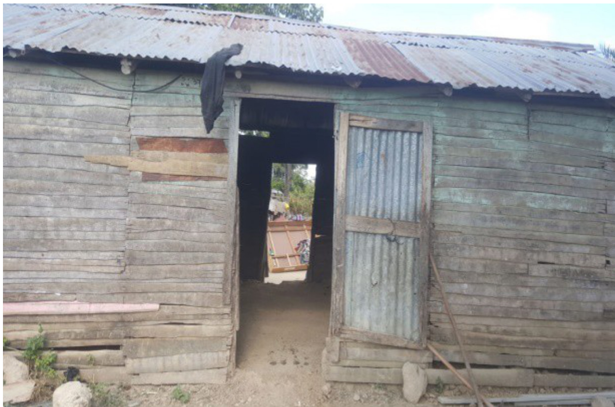
Ilustración 10. Vivienda con piso de tierra en la provincia Elías Piña
